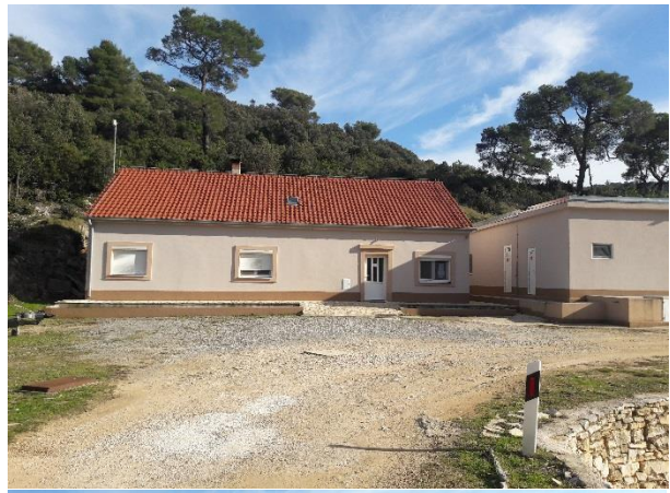
Stanje poslije izvođenja sanacije C.S. Korita
