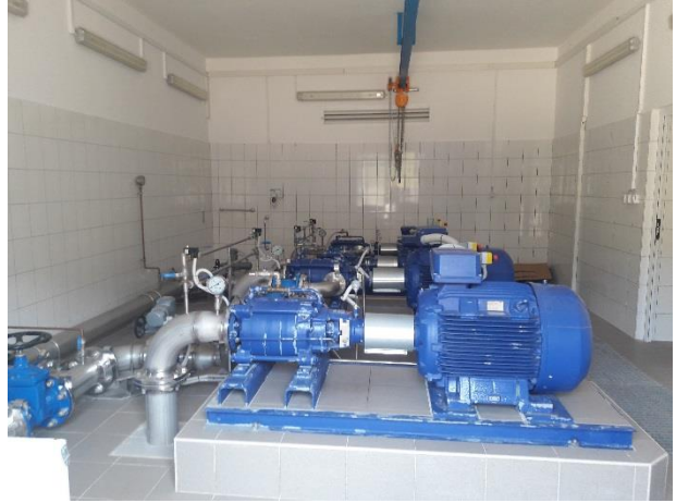
Stanje poslije izvođenja sanacije C.S. Korita
