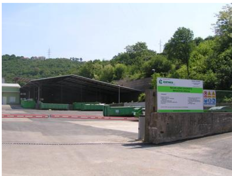
Slika 4. Primjer reciklažnog dvorišta
