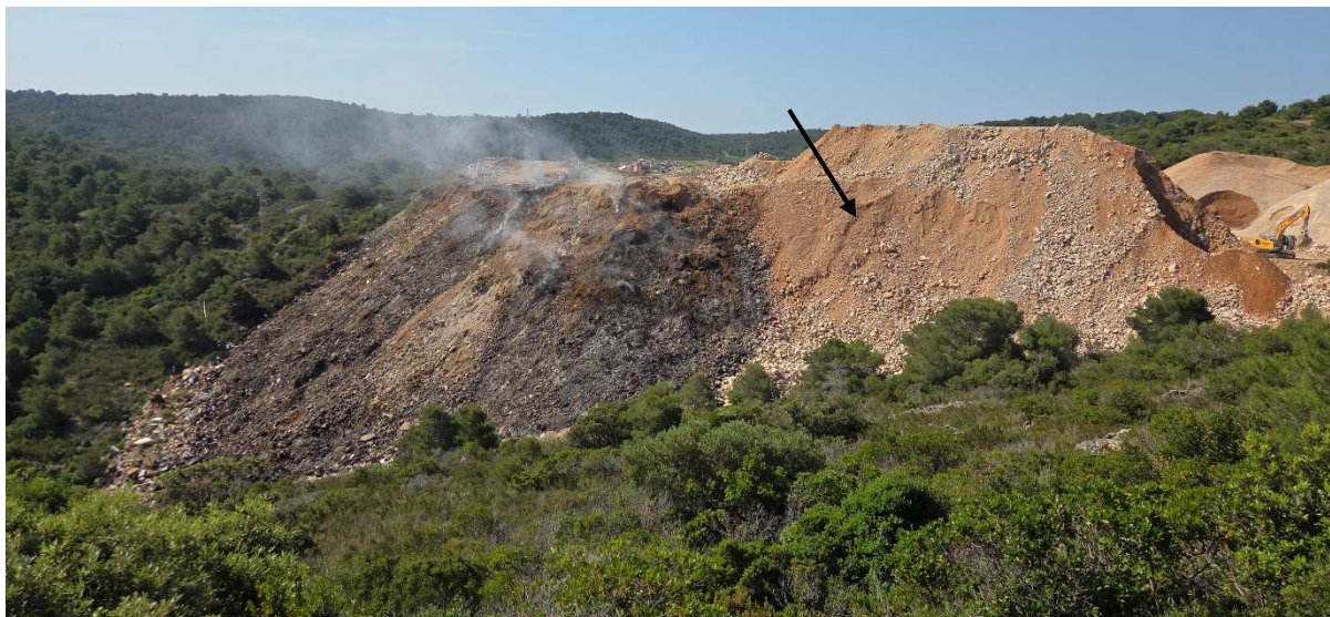
Slika 7 - Klizne plohe na uskladištenom inertnom materijalu
